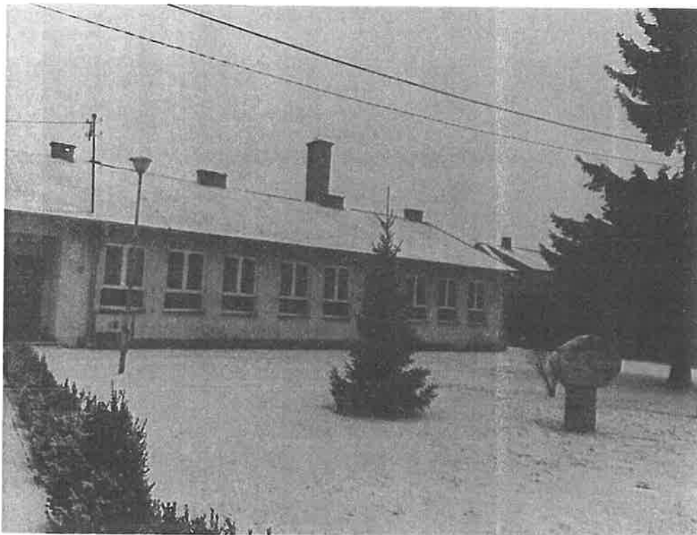
Fot. 2. Budynek SP Szestno.
