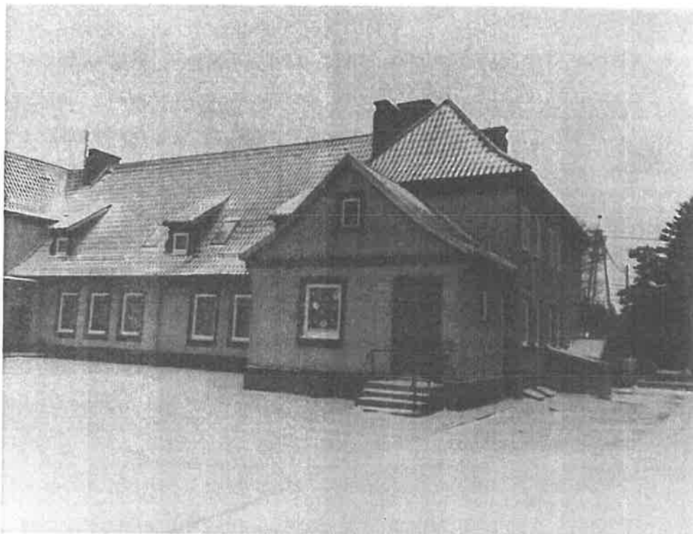
Fot. 3. Budynek SP w Marcinkowie.
