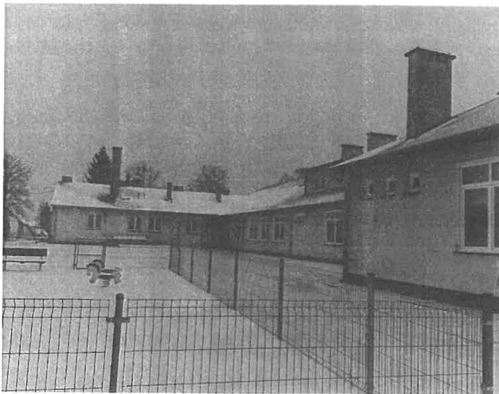
Fot. 6. Budynek SP Szestno
