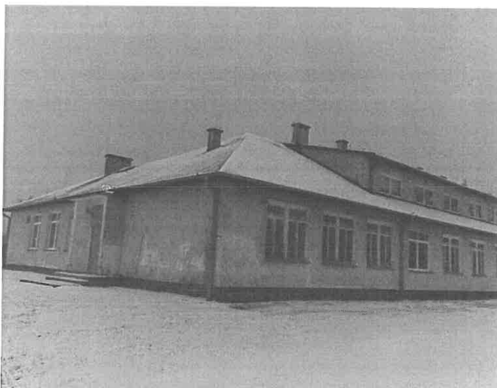
Fot. 5. Budynek SP Szestno
