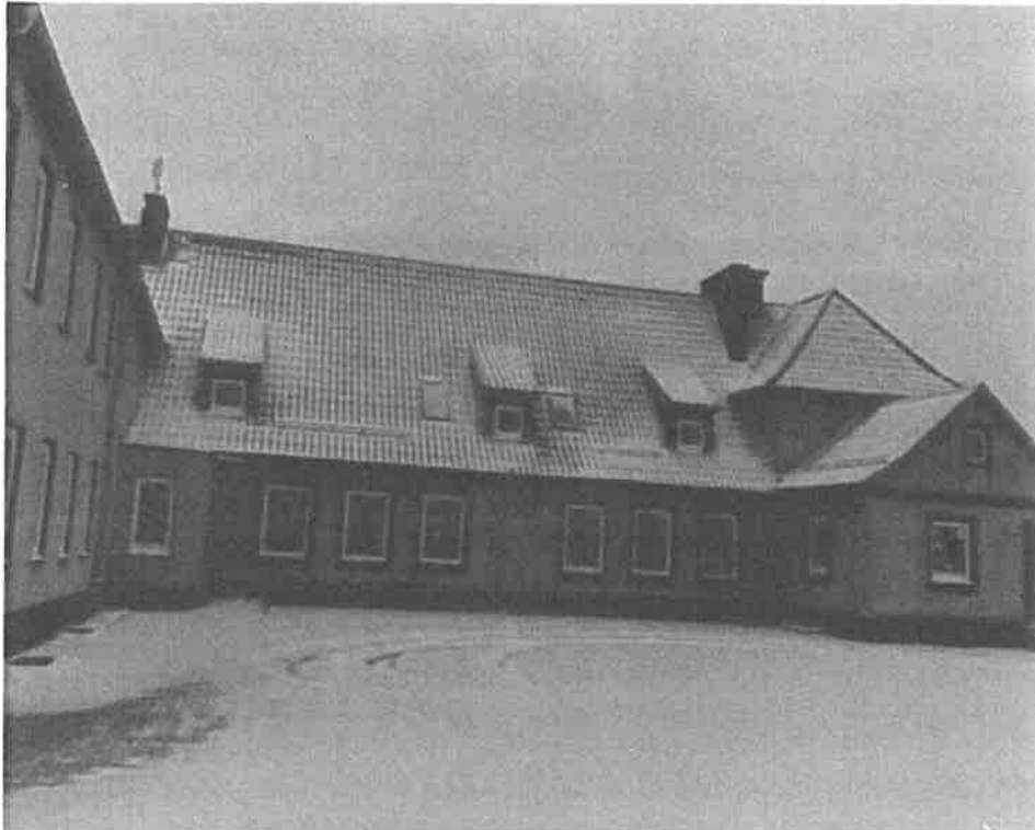
Fot. 4. Budynek SP w Marcinkowie
