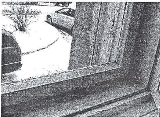
Próchniejące prowadnice żaluzji, progi, zewnętrzne ramiaki, przecieki wody deszczowej do wnętrza okna.
