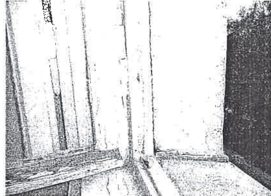
Spróchniałe, spękane i rozeschnięte progi, próchniejące wnętrza skrzynki okiennej świadczące o przedostawaniu się wody opadowej do wnętrza okna oraz pod okno.
