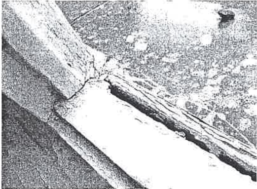
Spróchniałe, spękane i rozeschnięte progi, próchniejące wnętrza skrzynki okiennej świadczące o przedostawaniu się wody opadowej do wnętrza okna oraz pod okno.
