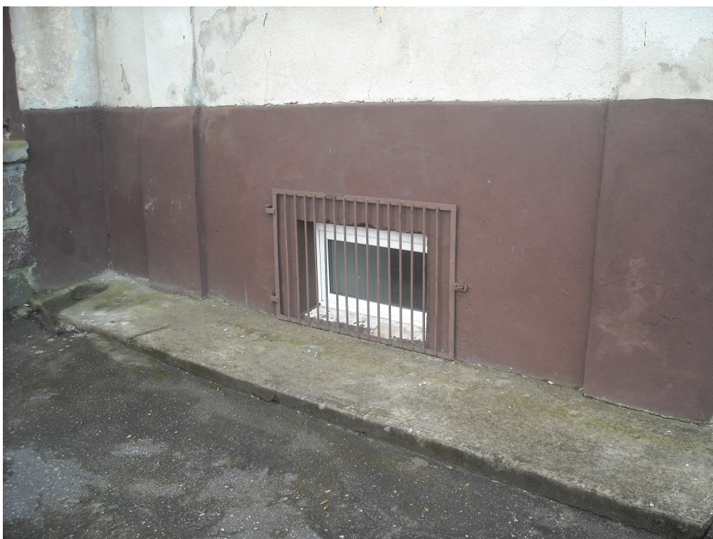
Fot. 11 Opaska betonowa w poziomie okna piwnicznego.
