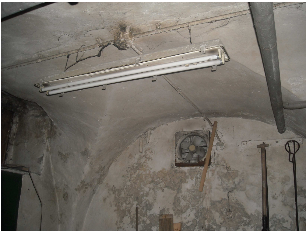
Fot 5. Widoczne wykwity solne na ścianie zewnętrznej.
