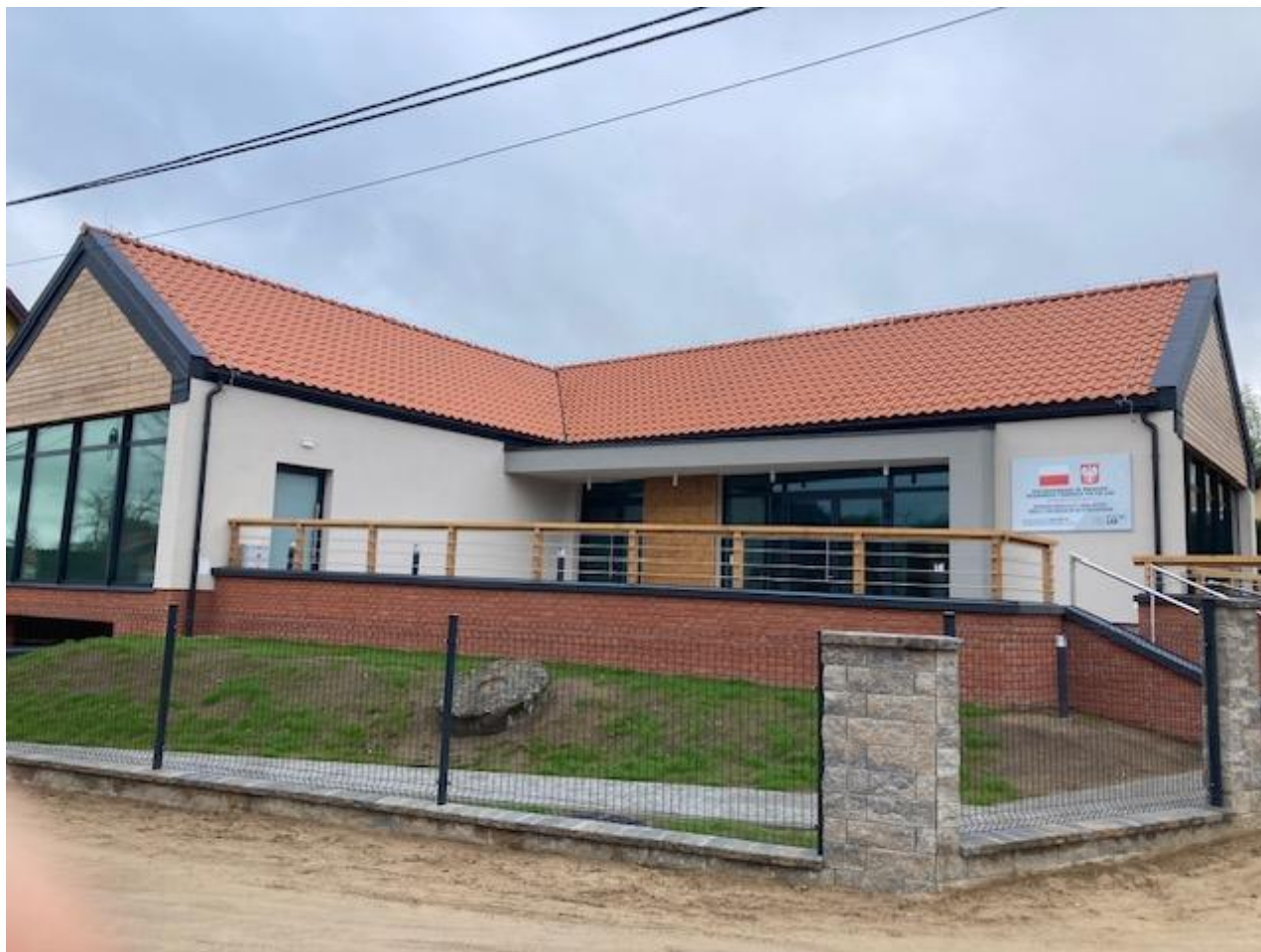
Zdj. Budynek świetlicy i biblioteki w Kosewie- widok od strony drogi gminnej.
