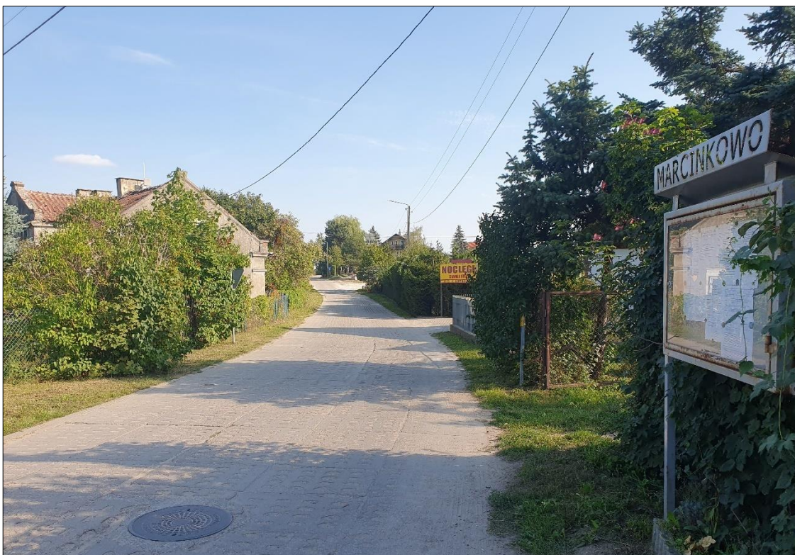
Fot. 2 Widok na drogę gminną, w pobliżu terenu 1KD (fot. własna)
