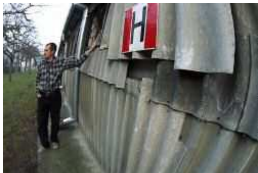
Rysunek 5 Ściana boczna budynku z płyt cementowo-azbestowych:
