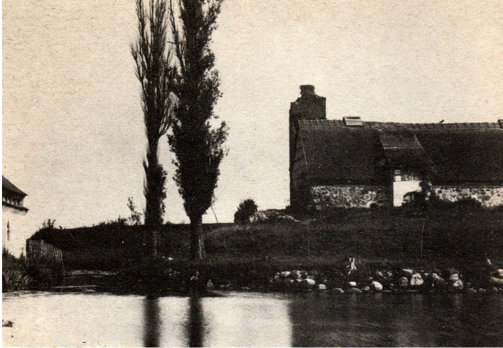
Ruiny wieży i stodoła zbudowana w miejscu dawnego folwarku krzyżackiego w Szestnie
